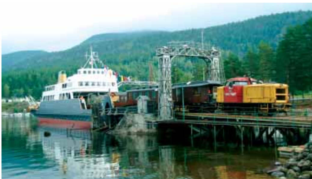
Jernbaneferja "Storegut" er en viktig del av Rjukanbanen og Verdensarv-prosjektet. Ferja ble rustet opp til 100-års jubileet og det ble arrangert turer på Tinnsjøen for interesserte. (Foto: Alexander Ytterborg, Riksantikvaren)
