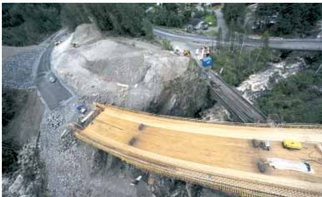
Fra Hjuksevelta-anlegget ved innkjøringen til Notodden fra sør. Fylkeskommunen har investert 56 mill. kroner i den 1,1 km lange strekningen med ny bru. Veien åpnet høsten 2009, og arbeidet blir avsluttet i mai 2010. (Foto: Torfinn Skåttet)
